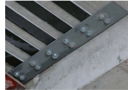
Mechanical anchorage, (Kalfat et al., 2013).
